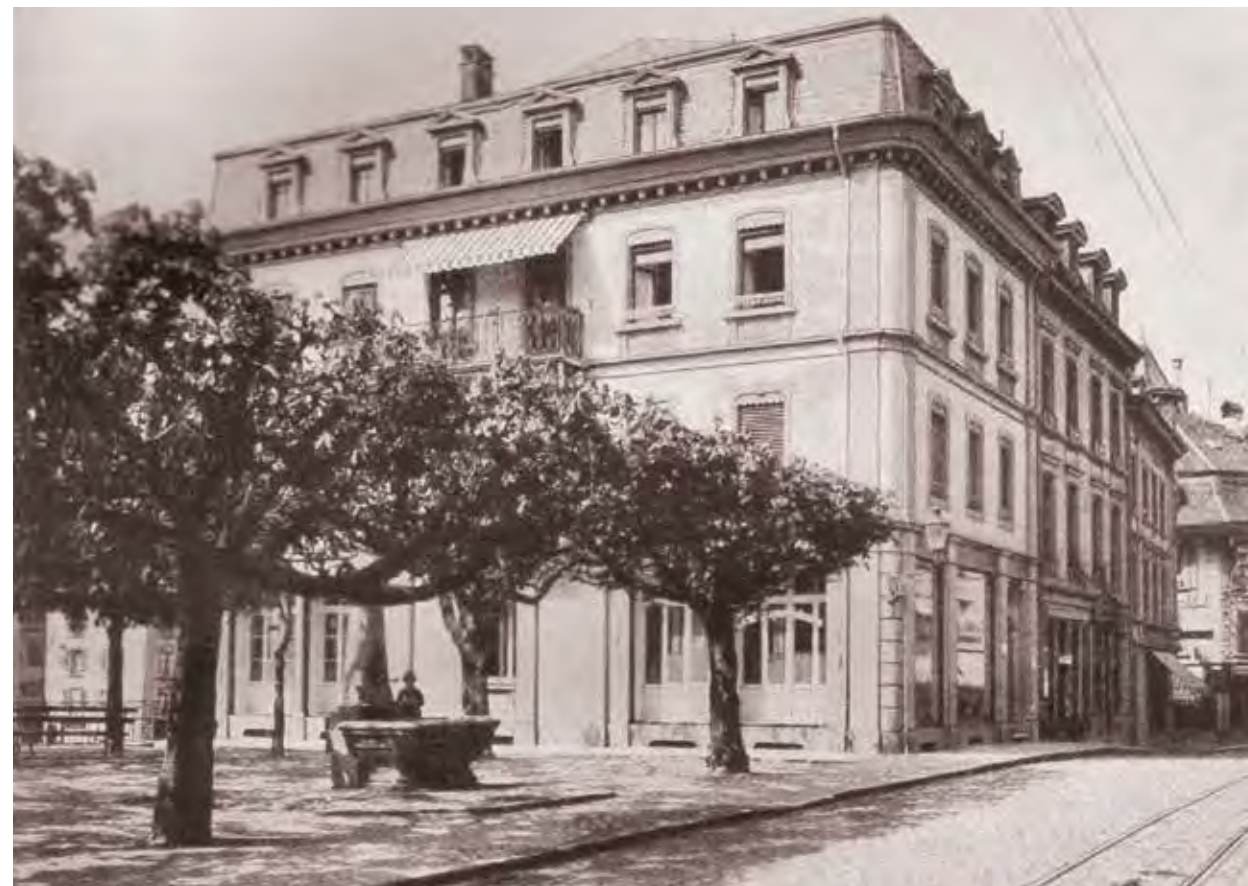
Studerhaus am Plätzli: Kassagebäude der Amtersparniskasse Thun, 1900. Quelle: Hundert Jahre Amtersparniskasse Thun, 1826 -1926, Ein Beitrag zur Heimatkunde, Dr. Martin Trepp.
