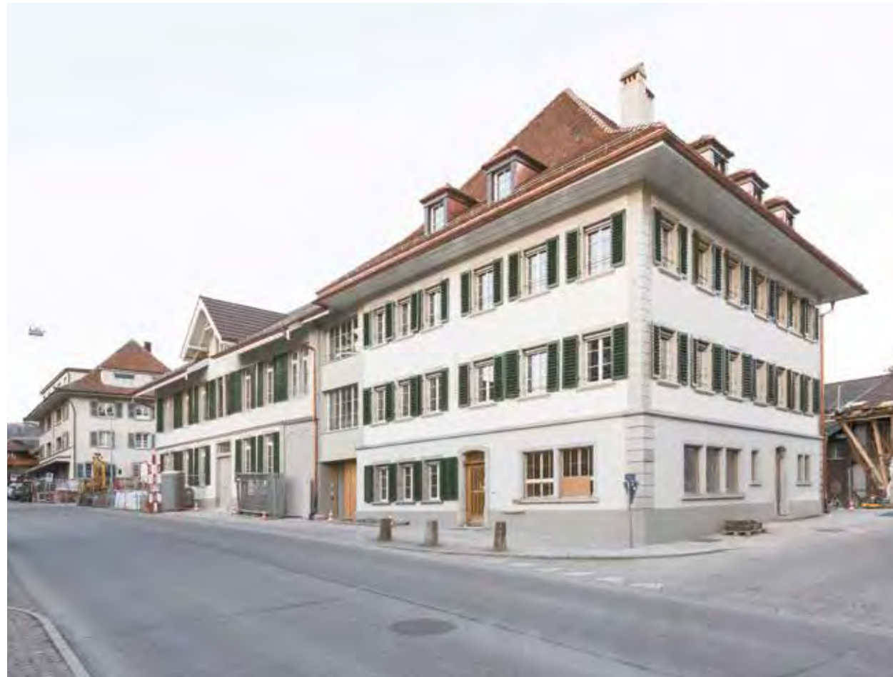
Das historisch wertvolle Landhaus Steffisburg erstrahlt als modernes Gesundheitszentrum in neuem Glanz.
